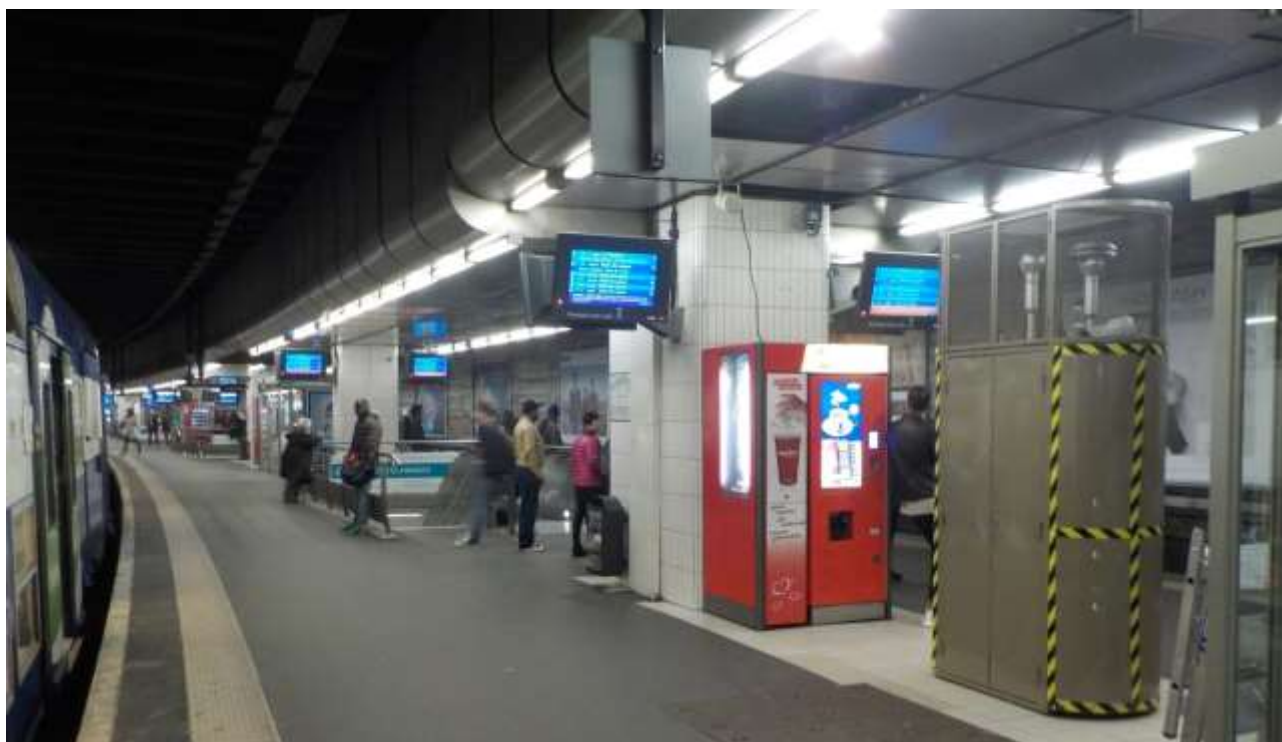
Photographie 1 : Emplacement de la baie de mesure sur le quai n°2
